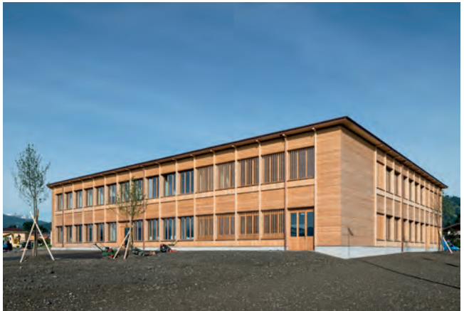
«Rhyboot»-Neubau «Bleiche», Altstätten SG
